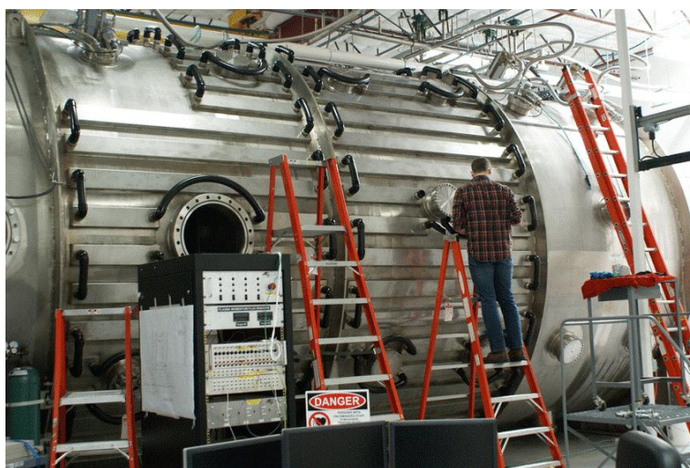
Рис. 6. Панели водяного охлаждения камеры “El Monstruo”.
